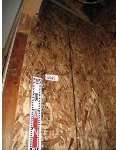
構造用パネル(OSB)N50@150固定
