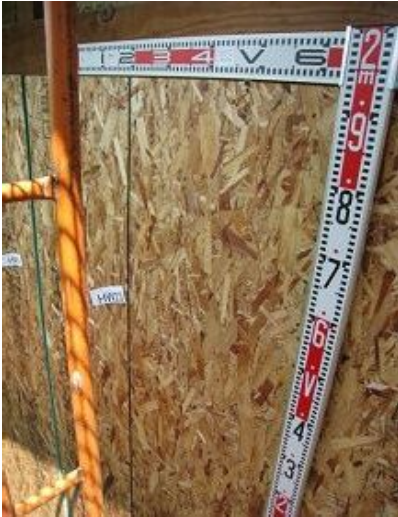
構造用パネル(OSB)N50@150固定
