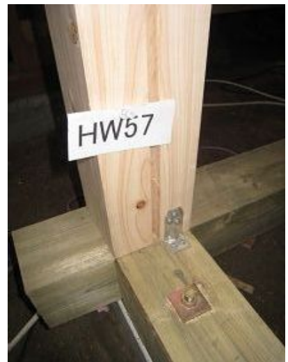
左下柱脚固定金物
