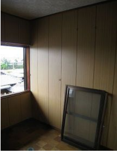
施工前(洋間側)
