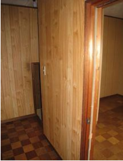
施工前(廊下側)
