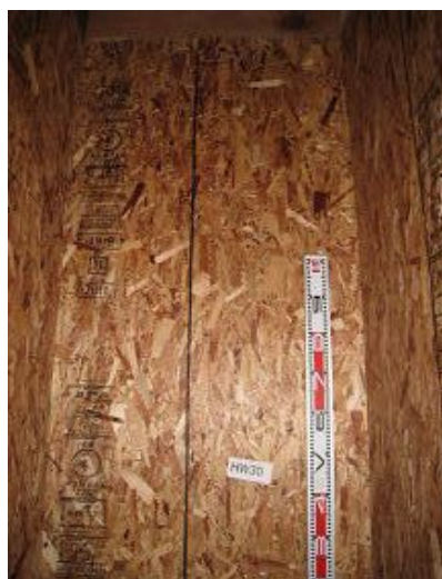
構造用パネル(OSB)N50@150固定
