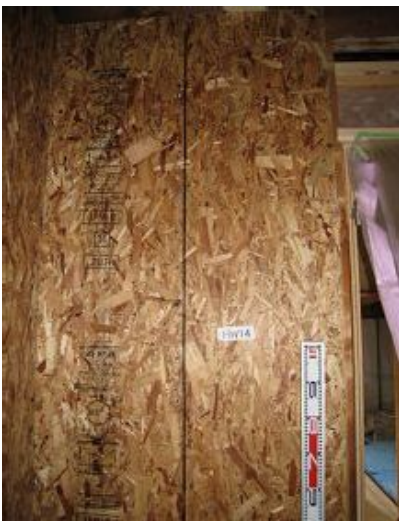
構造用パネル(OSB)N50@150固定
