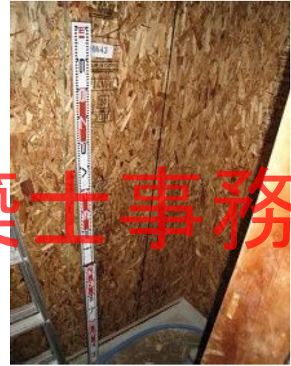
構造用パネル(OSB)N50@150固定(浴室側完了)
