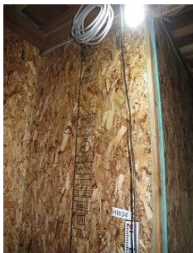
構造用パネル(OSB)N50@150固定
