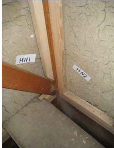
右下柱脚通し柱のため金物無し
