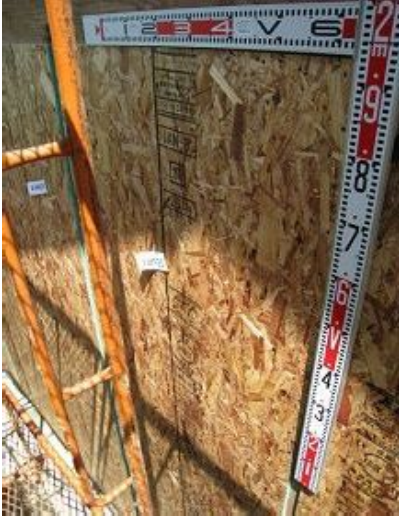
構造用パネル(OSB)N50@150固定
