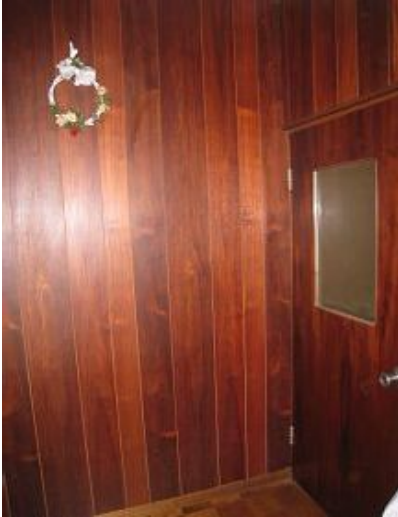
施工前(ホール側)
