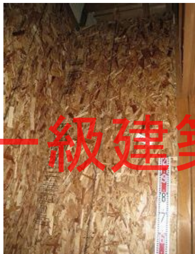
構造用パネル(OSB)N50@150固定
