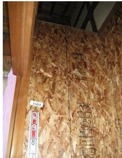
構造用パネル(OSB)N50@150固定
