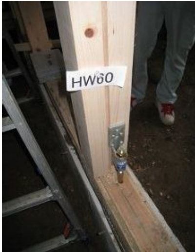
左下柱脚固定金物
