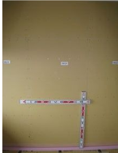
石膏ボード t=12.5\text{mm} 張り(胴縁仕様)
