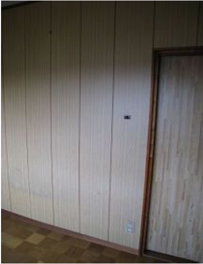
施工前(洋間側)
