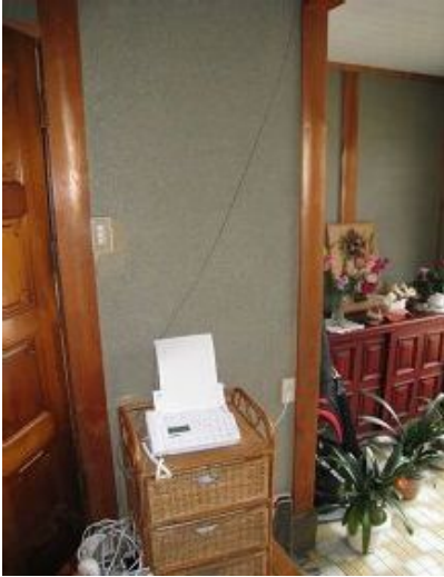
施工前(玄関側)
