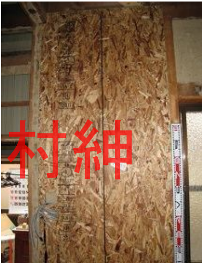
構造用パネル(OSB)N50@150固定
