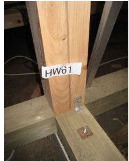
左下柱脚固定金物
