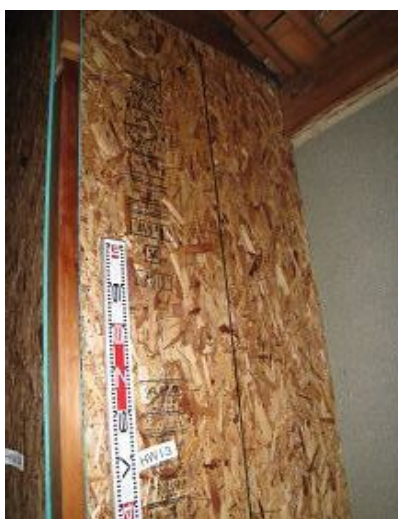
構造用パネル(OSB)N50@150固定
