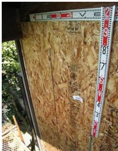
構造用パネル(OSB)N50@150固定
