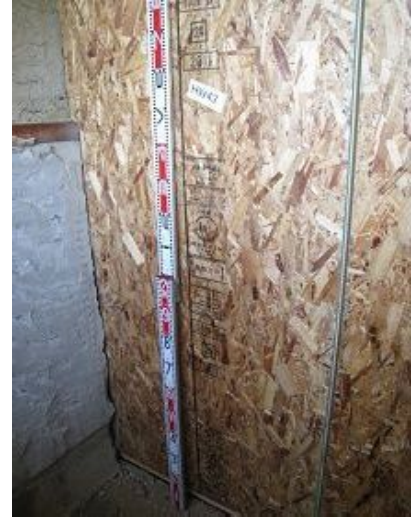
構造用パネル(OSB)N50@150固定(浴室側完了)
