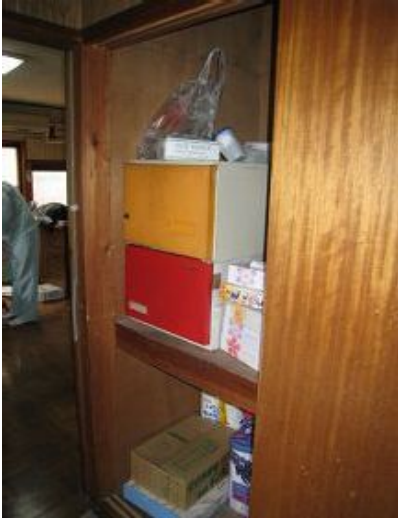
施工前(押入側)
