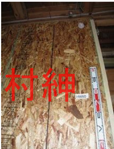
構造用パネル(OSB)N50@150固定
