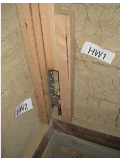
左下柱脚固定金物
