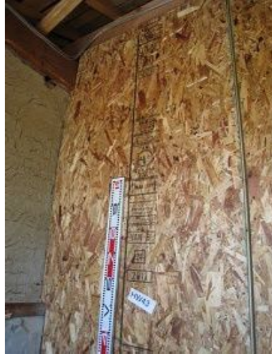
構造用パネル(OSB)N50@150固定(浴室側完了)
