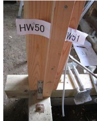
左下柱脚固定金物
