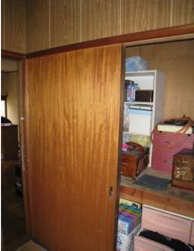
施工前(押入側)
