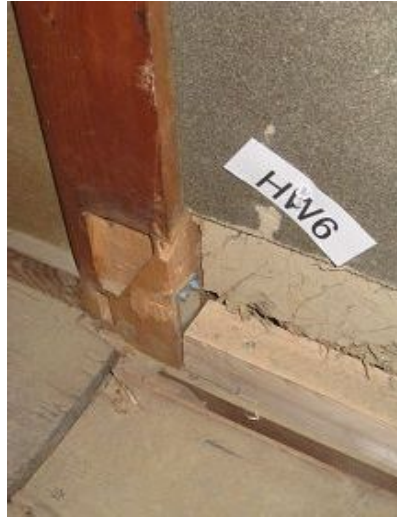
左下柱脚固定金物
