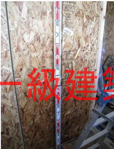
構造用パネル(OSB)N50@150固定(浴室側完了)
