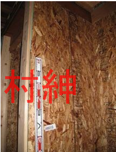
構造用パネル(OSB)N50@150固定
