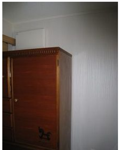
完了(洗面室側)
