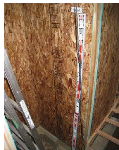
構造用パネル(OSB)N50@150固定
