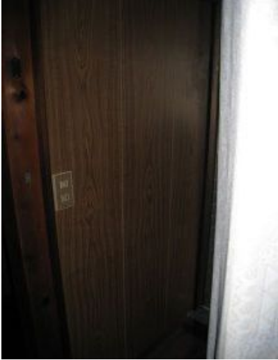
施工前(洗面側)
