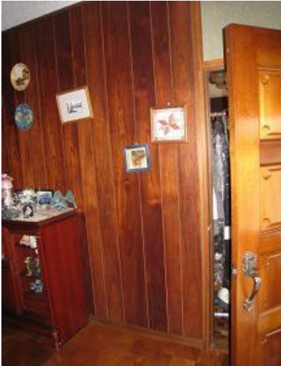
施工前(ホール側)
