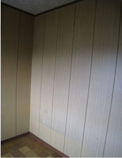
施工前(室内側)
