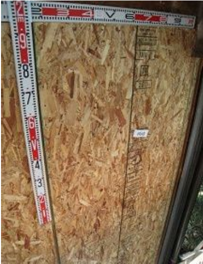
構造用パネル(OSB)N50@150固定
