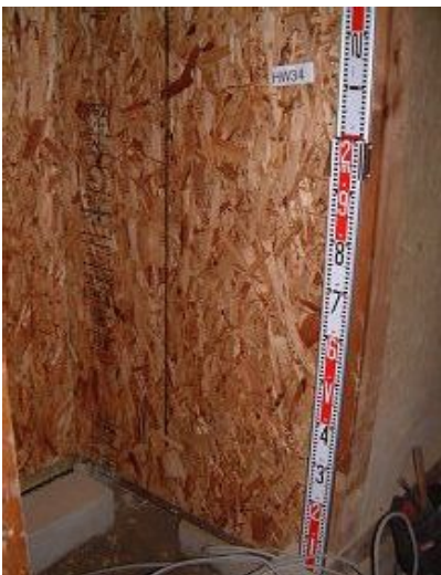
構造用パネル(OSB)N50@150固定
