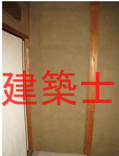
施工前(和室側)
