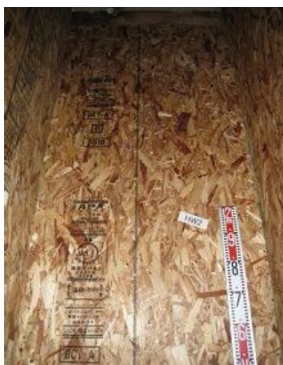
構造用パネル(OSB)N50@150固定
