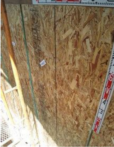
構造用パネル(OSB)N50@150固定
