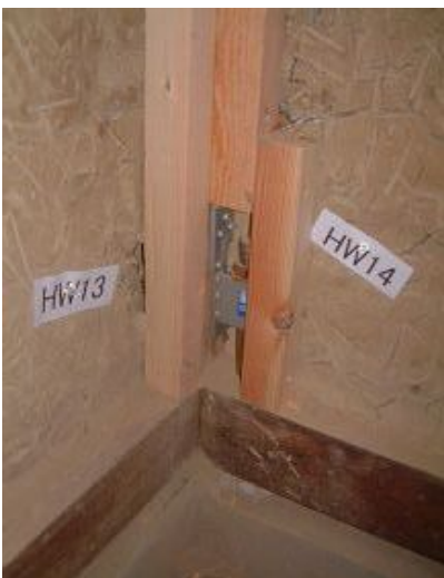
左下柱脚固定金物
