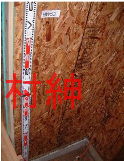
構造用パネル(OSB)N50@150固定
