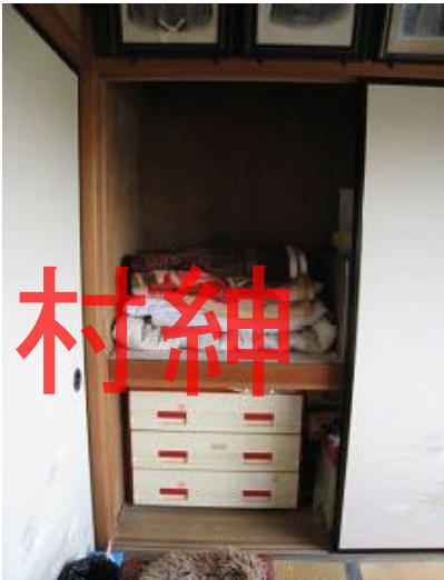
施工前(押入側)
