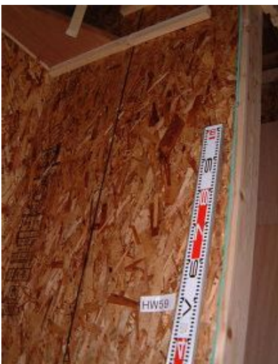
構造用パネル(OSB)N50@150固定
