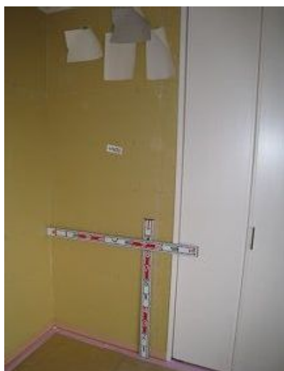
石膏ボードt=12.5mm張り(胴縁仕様) 完了
