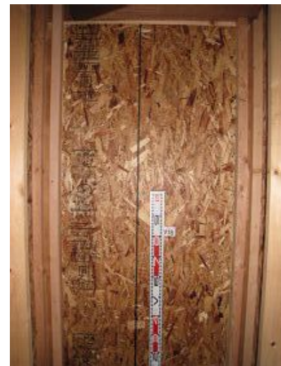
構造用パネル(OSB)N50@150固定
