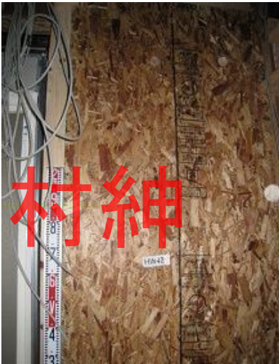
構造用パネル(OSB)N50@150固定
