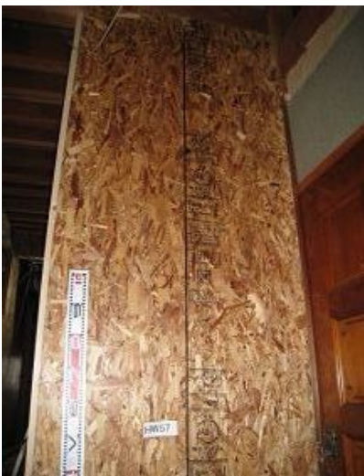
構造用パネル(OSB)N50@150固定
