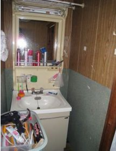
施工前(洗面側)
