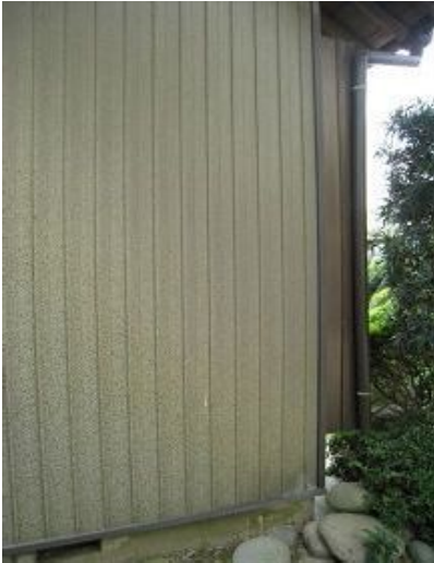
施工前(外部側)
