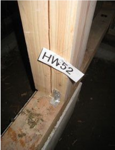
左下柱脚固定金物
