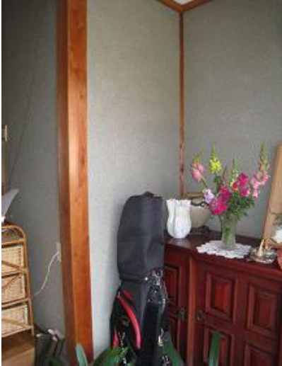
施工前(玄関側)
