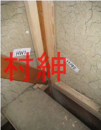
左下柱脚固定金物
