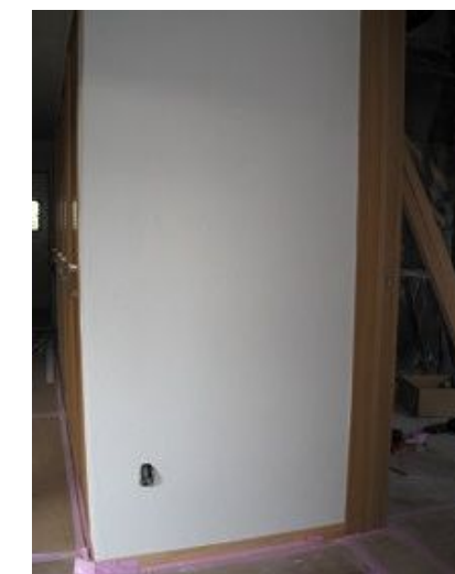
完了(玄関ホール側)
