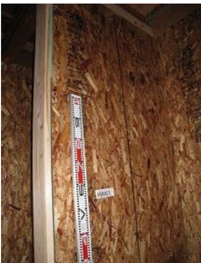
構造用パネル(OSB)N50@150固定
