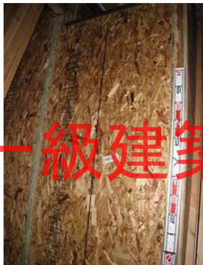
構造用パネル(OSB)N50@150固定
