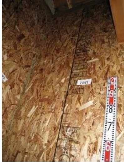
構造用パネル(OSB)N50@150固定
