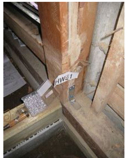
左下柱脚固定金物
