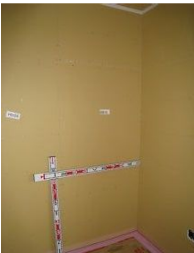
石膏ボード t=12.5\text{mm} 張り(胴縁仕様)
