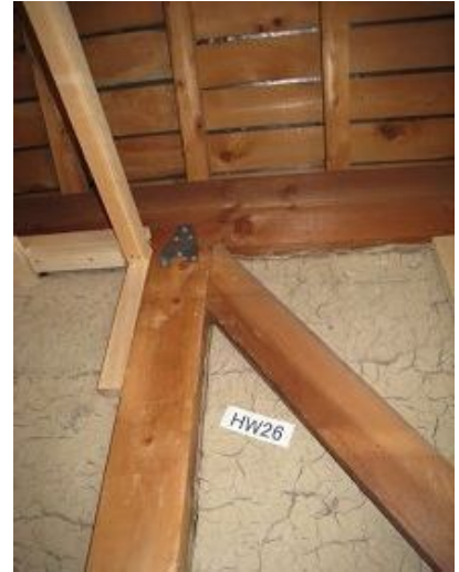
左上柱頭固定金物 通し柱のため柱脚固定金物無し
