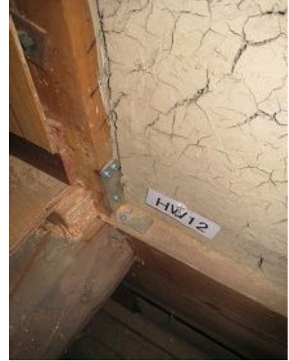
左下柱脚固定金物
