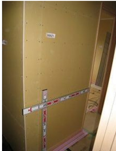
石膏ボード t=12.5\text{mm} 張り(胴縁仕様) 完了
