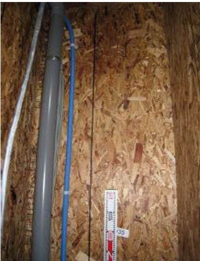
構造用パネル(OSB)N50@150固定
