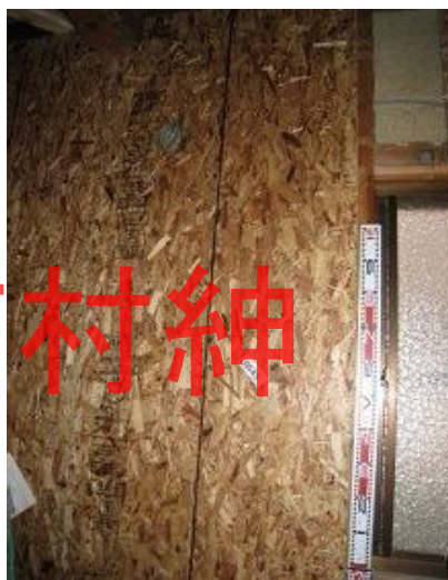
構造用パネル(OSB)N50@150固定
