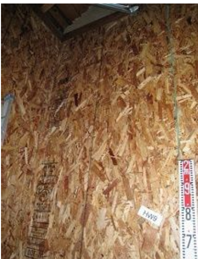
構造用パネル(OSB)N50@150固定
