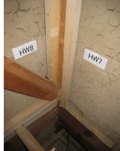
左下柱脚固定金物
