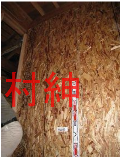
構造用パネル(OSB)N50@150固定
