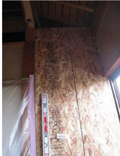
構造用パネル(OSB)N50@150固定
