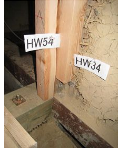
左下柱脚固定金物
