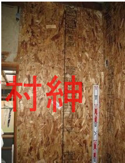
構造用パネル(OSB)N50@150固定
