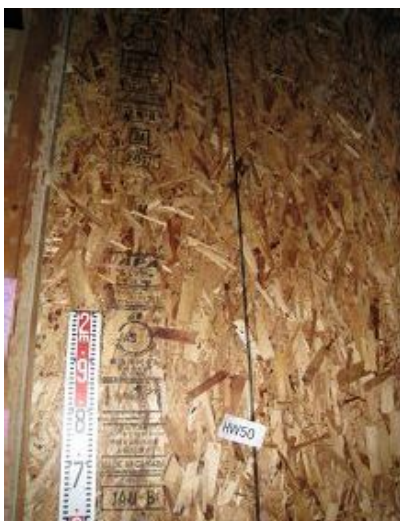
構造用パネル(OSB)N50@150固定
