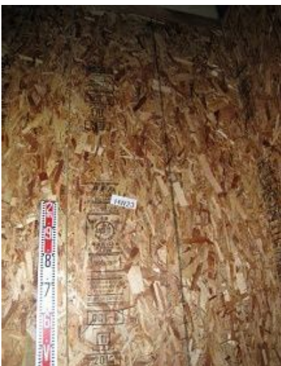
構造用パネル(OSB)N50@150固定
