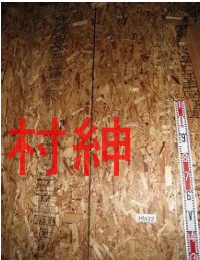
構造用パネル(OSB)N50@150固定
