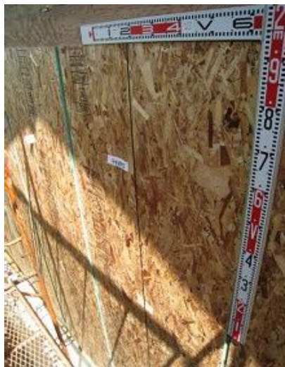
構造用パネル(OSB)N50@150固定
