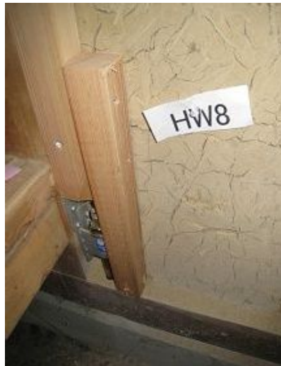
左下柱脚固定金物
