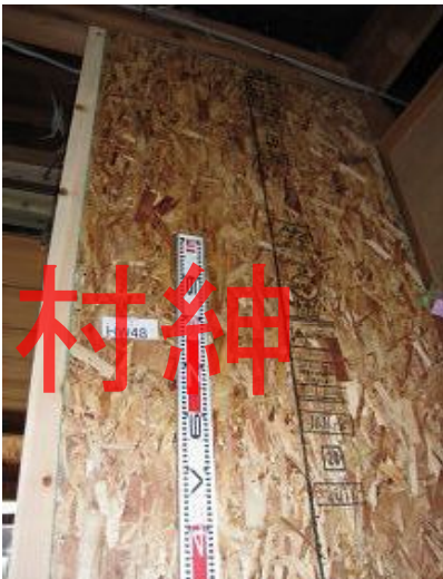
構造用パネル(OSB)N50@150固定
