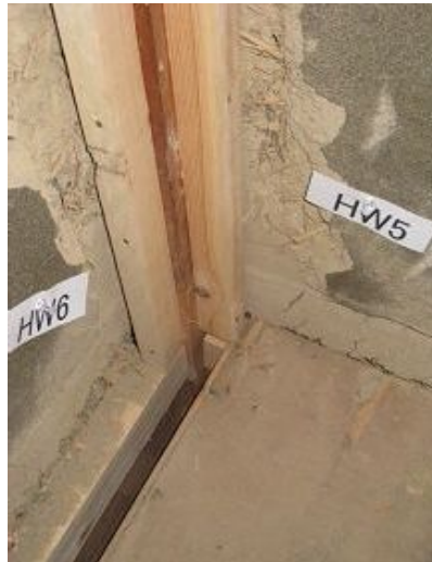
左下柱脚固定金物
