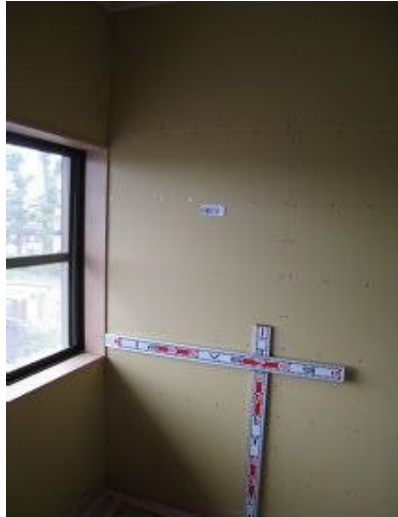
石膏ボード t=12.5\text{mm} 張り(胴縁仕様)
