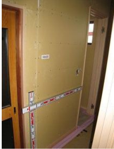
石膏ボード t=12.5\text{mm} 張り(胴縁仕様) 完了
