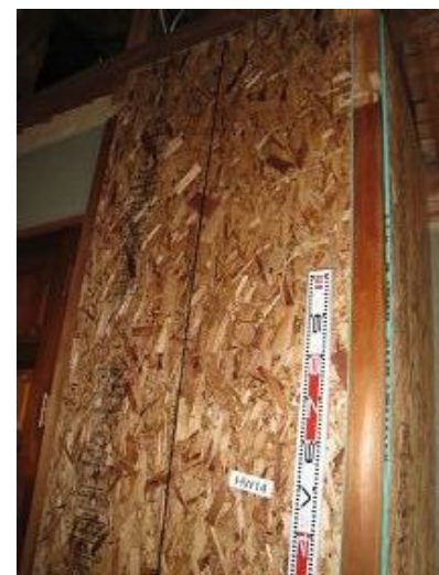
構造用パネル(OSB)N50@150固定
