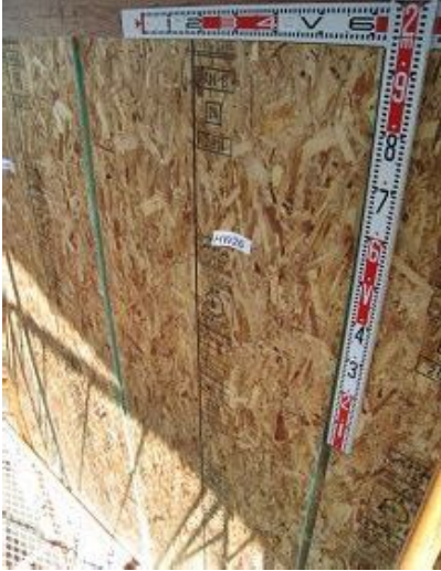
構造用パネル(OSB)N50@150固定
