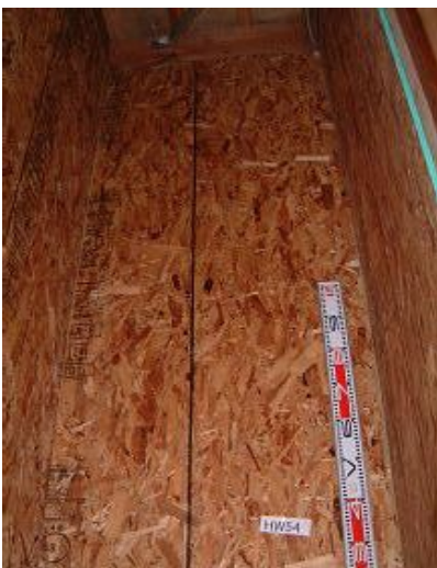
構造用パネル(OSB)N50@150固定
