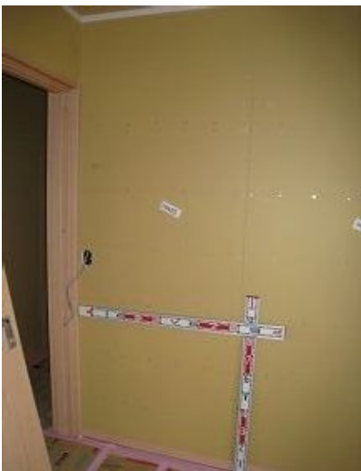
石膏ボード t=12.5\text{mm} 張り(胴縁仕様)
