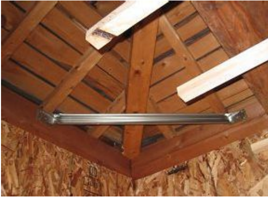
鋼製火打ち取付
