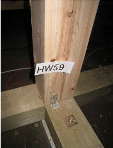
左下柱脚固定金物
