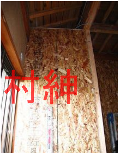
構造用パネル(OSB)N50@150固定
