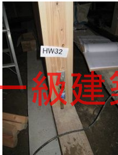
左下柱脚固定金物
