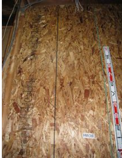
構造用パネル(OSB)N50@150固定
