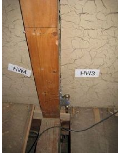
左下柱脚固定金物
