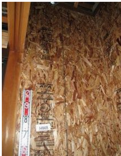
構造用パネル(OSB)N50@150固定
