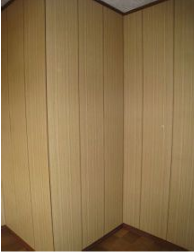
施工前(洋間側)
