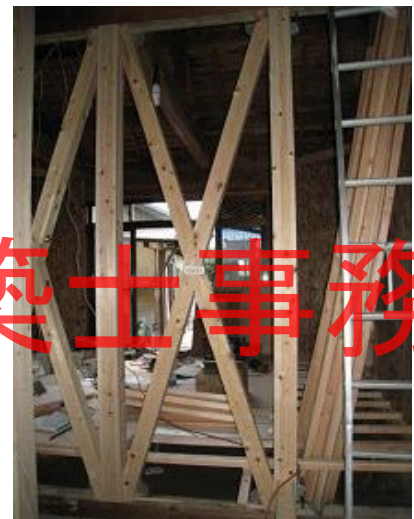
筋交ダブル90×90取付 完了
