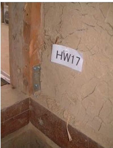
左下柱脚固定金物
