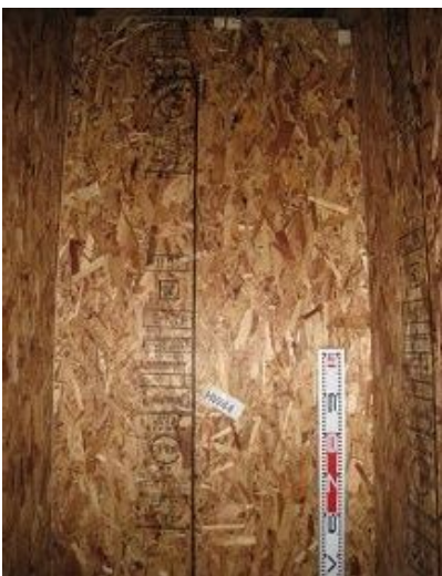
構造用パネル(OSB)N50@150固定
