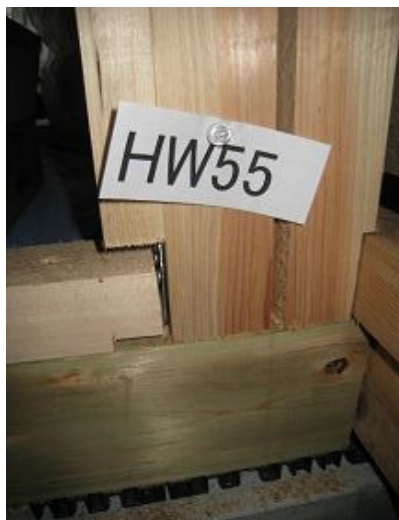
左下柱脚固定金物
