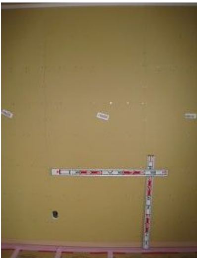
石膏ボード t=12.5\text{mm} 張り(胴縁仕様)
