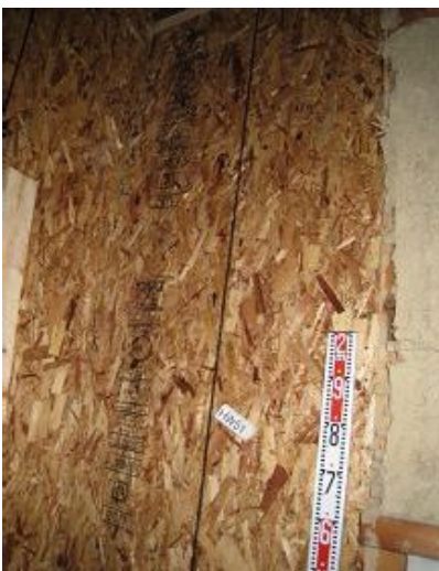
構造用パネル(OSB)N50@150固定
