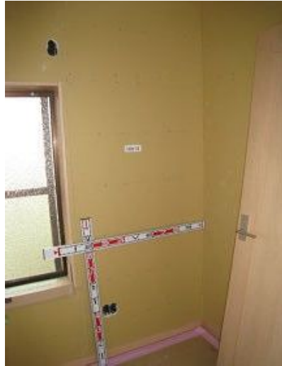
石膏ボード t=12.5\text{mm} 張り(胴縁仕様)
