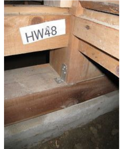
左下柱脚固定金物
