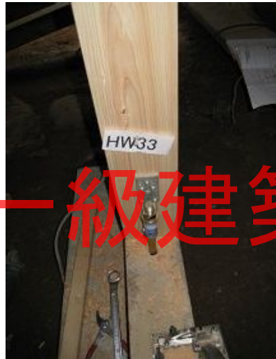
左下柱脚固定金物
