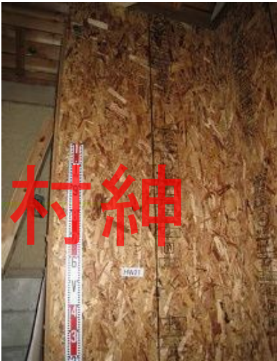
構造用パネル(OSB)N50@150固定
