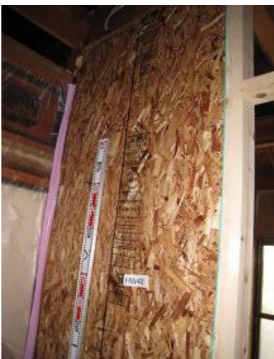
構造用パネル(OSB)N50@150固定
