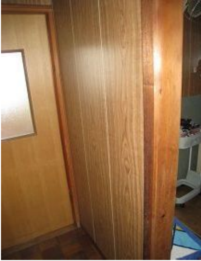
施工前(廊下側)
