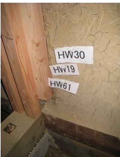
左下柱脚固定金物
