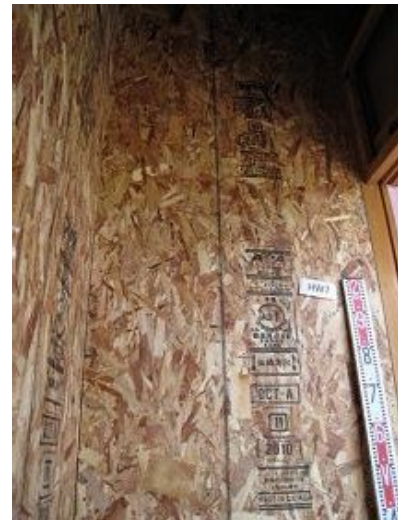
構造用パネル(OSB)N50@150固定
