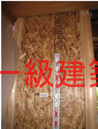
構造用パネル(OSB)N50@150固定
