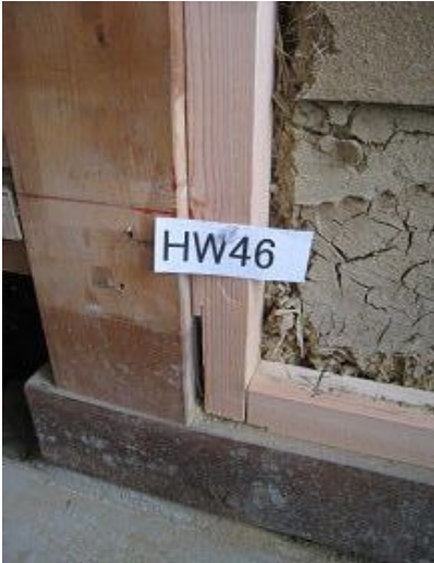
左下柱脚固定金物
