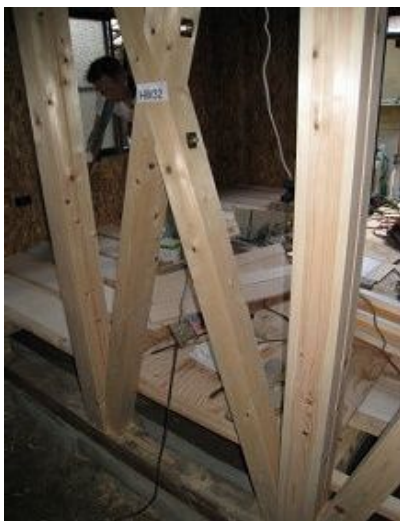
筋交ダブル90×90取付 完了
