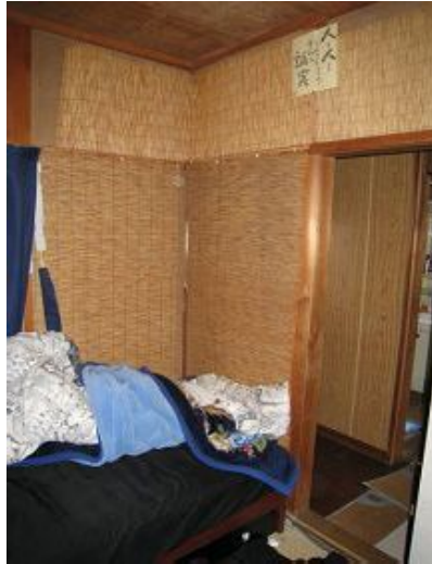
施工前(和室側)
