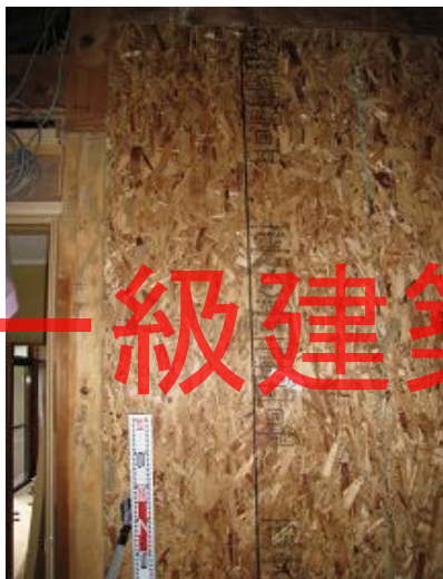
構造用パネル(OSB)N50@150固定
