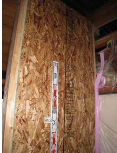
構造用パネル(OSB)N50@150固定
