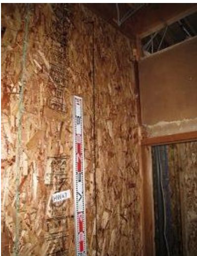
構造用パネル(OSB)N50@150固定
