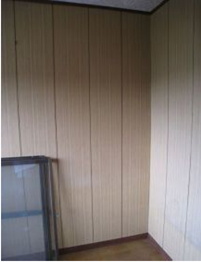
施工前(洋間側)
