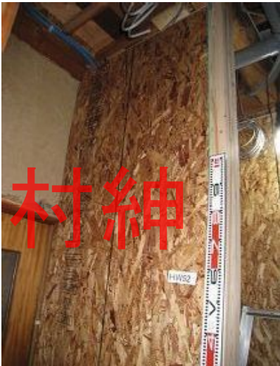
構造用パネル(OSB)N50@150固定
