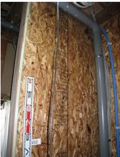
構造用パネル(OSB)N50@150固定
