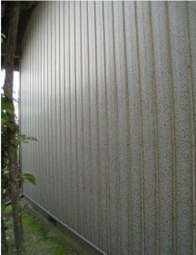
施工前(外部側)
