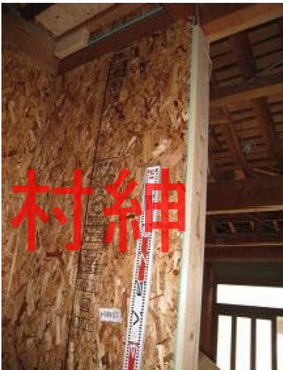
構造用パネル(OSB)N50@150固定
