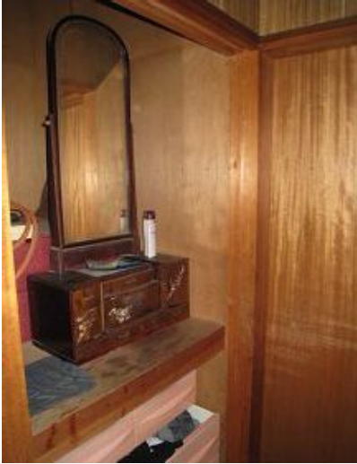
施工前(押入側)
