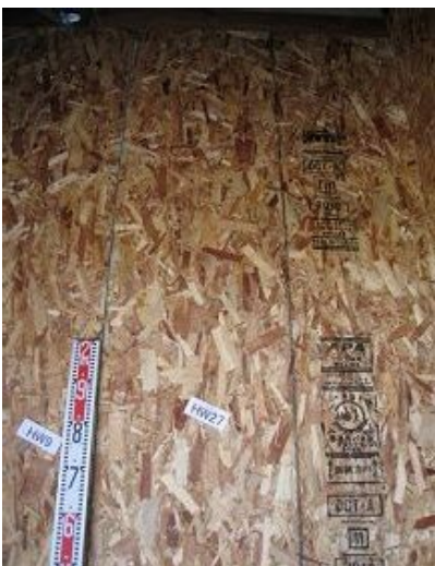
構造用パネル(OSB)N50@150固定
