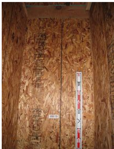
構造用パネル(OSB)N50@150固定
