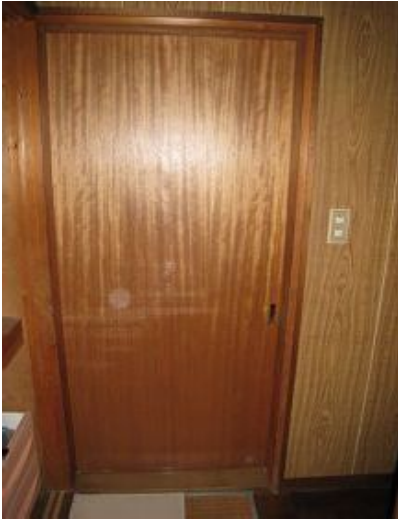
施工前(廊下側)
