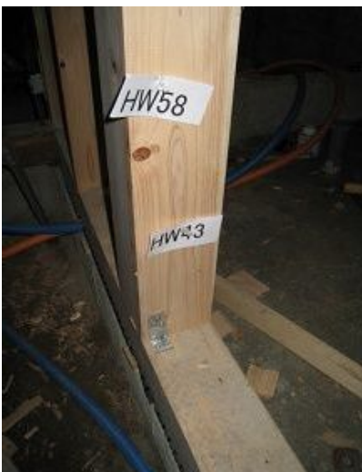
左下柱脚固定金物
