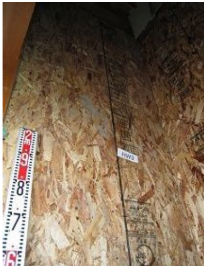
構造用パネル(OSB)N50@150固定
