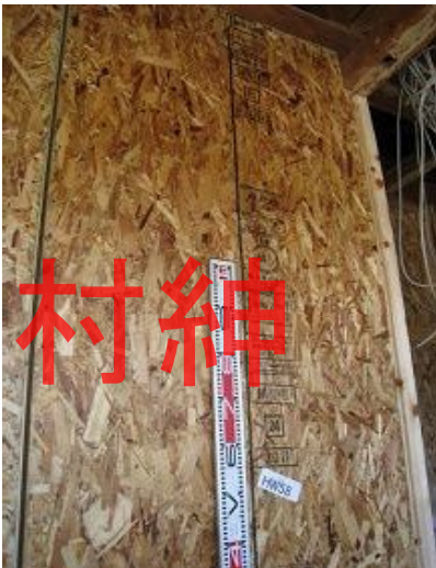
構造用パネル(OSB)N50@150固定(浴室側完了)
