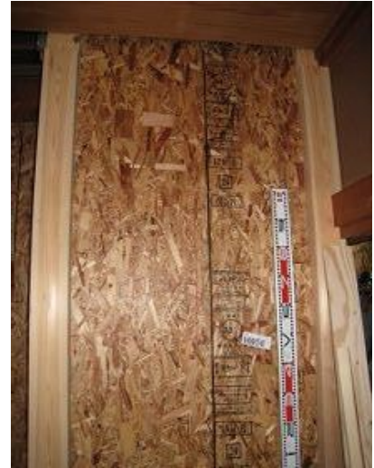
構造用パネル(OSB)N50@150固定
