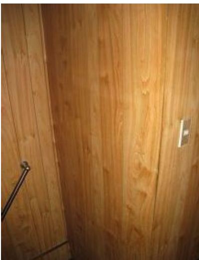
施工前(階段側)
