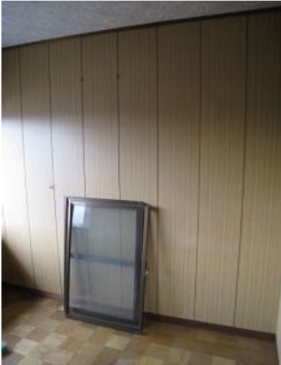
施工前(洋間側)
