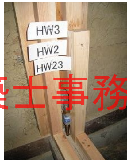
左下柱脚固定金物
