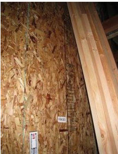
構造用パネル(OSB)N50@150固定
