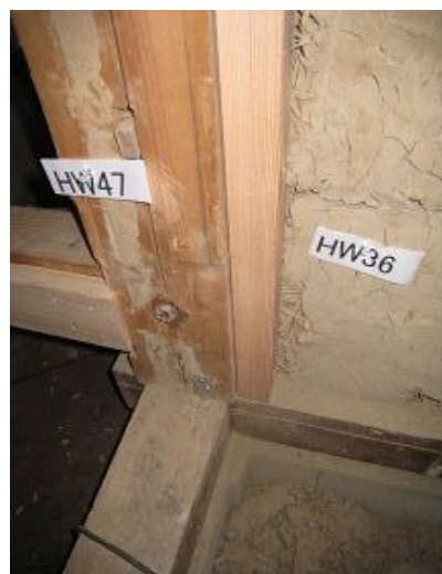
左下柱脚固定金物
