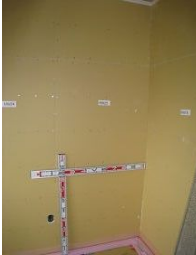
石膏ボード t=12.5\text{mm} 張り(胴縁仕様)
