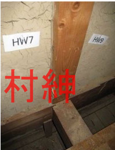
左下柱脚固定金物
