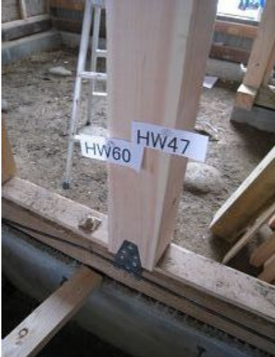
左下柱脚固定金物
