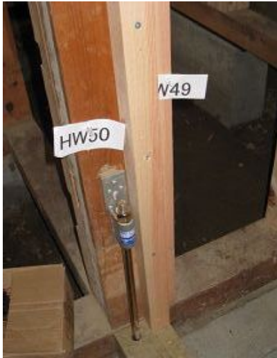
左下柱脚固定金物
