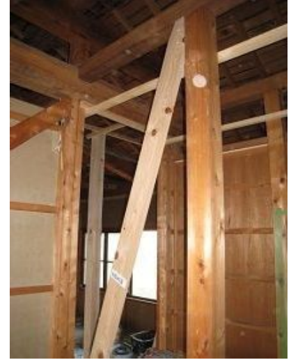
筋交:45×90取付(端部金物固定)
