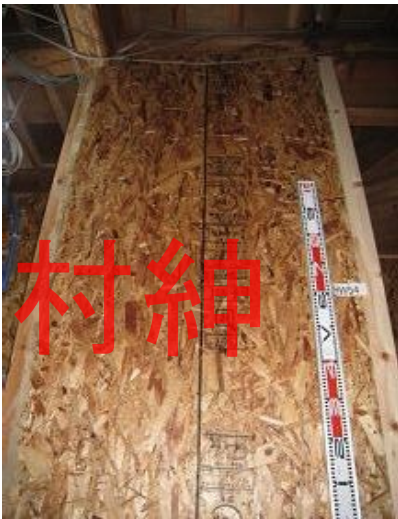
構造用パネル(OSB)N50@150固定
