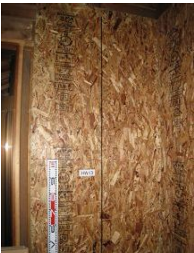
構造用パネル(OSB)N50@150固定
