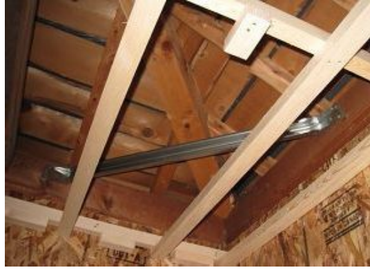
鋼製火打ち取付
