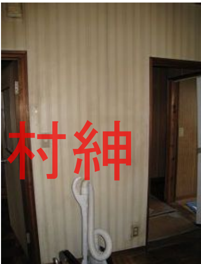
施工前(居間側)
