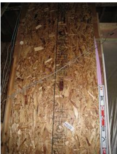
構造用パネル(OSB)N50@150固定
