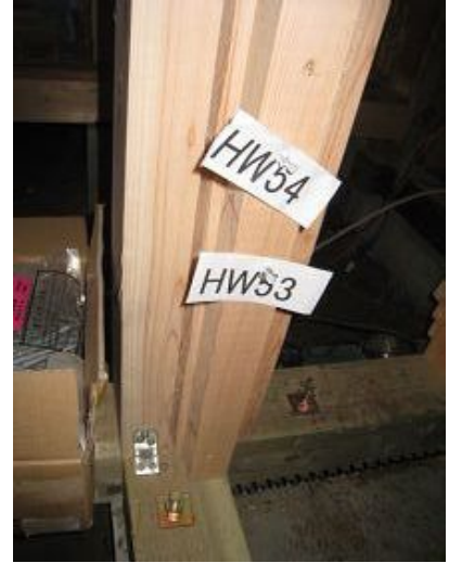
左下柱脚固定金物
