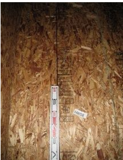
構造用パネル(OSB)N50@150固定
