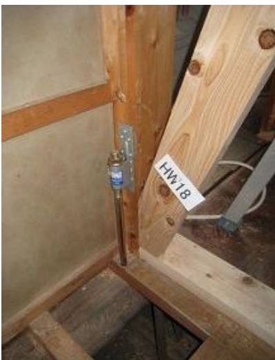
左下柱脚固定金物
