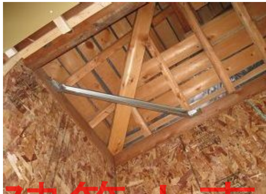
鋼製火打ち取付
