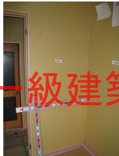
石膏ボード t=12.5\text{mm} 張り(胴縁仕様)
