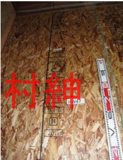
構造用パネル(OSB)N50@150固定
