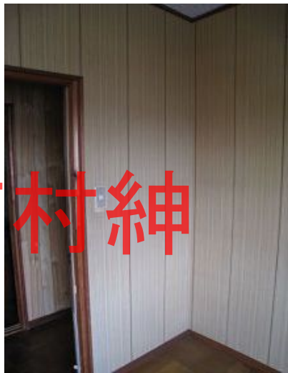
施工前(洋間側)
