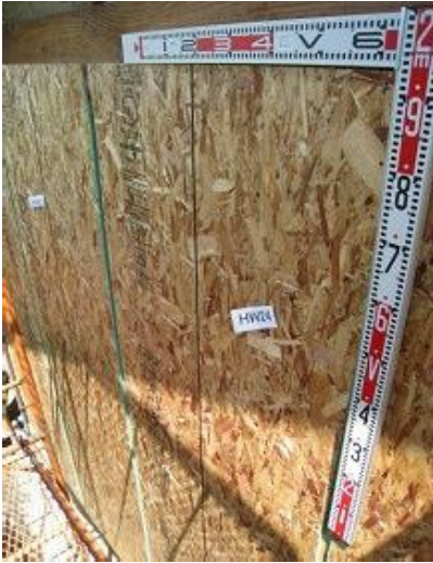
構造用パネル(OSB)N50@150固定
