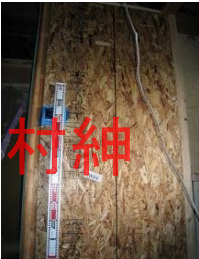
構造用パネル(OSB)N50@150固定
