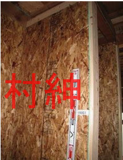
構造用パネル(OSB)N50@150固定
