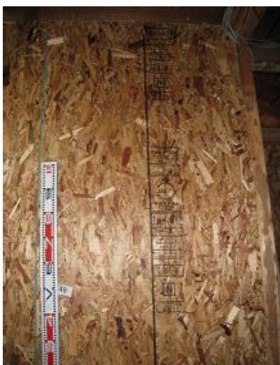
構造用パネル(OSB)N50@150固定
