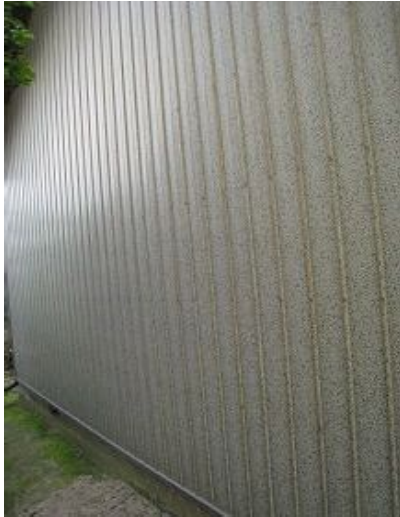
施工前(外部側)
