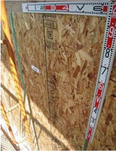
構造用パネル(OSB)N50@150固定
