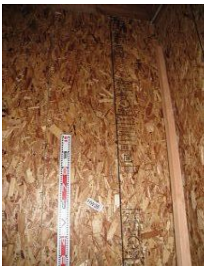
構造用パネル(OSB)N50@150固定
