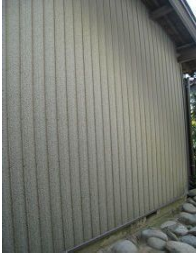
施工前(外部側)
