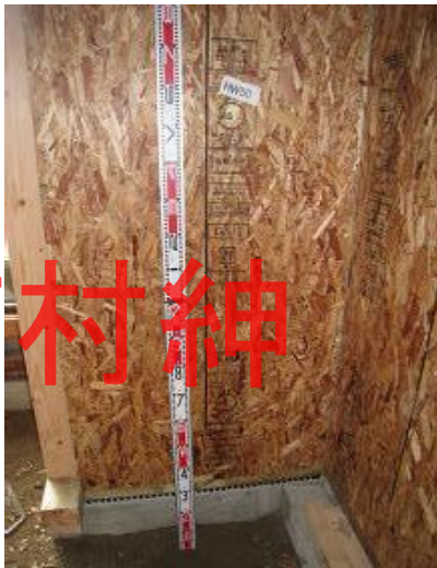
構造用パネル(OSB)N50@150固定
