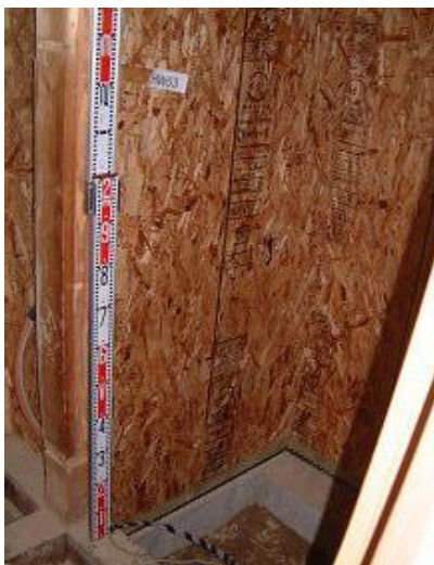
構造用パネル(OSB)N50@150固定
