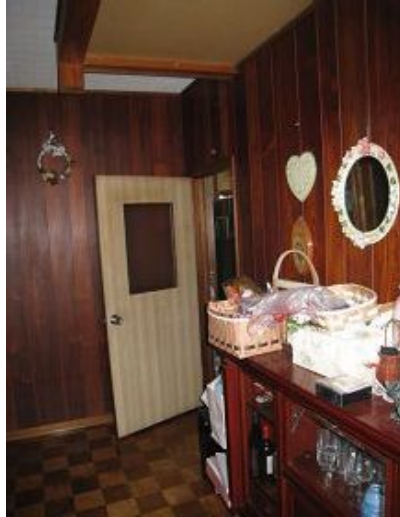
施工前ホール側)
