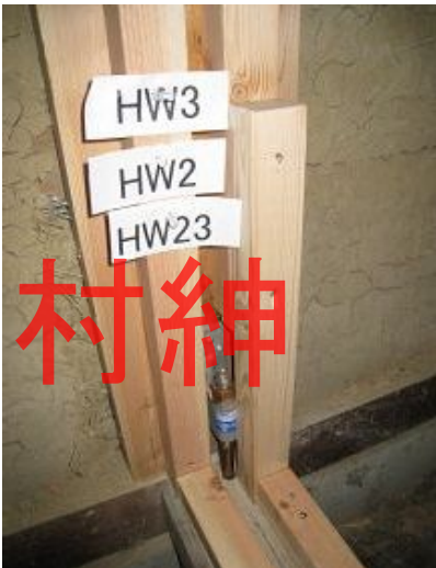
左下柱脚固定金物
