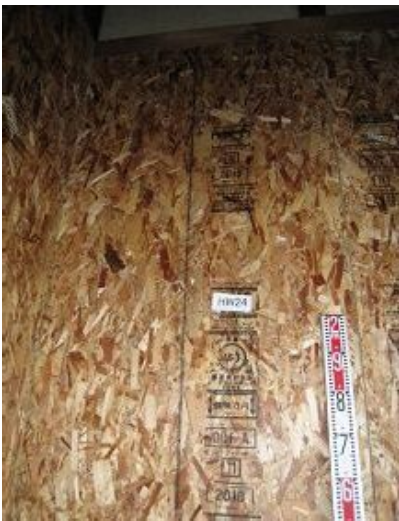
構造用パネル(OSB)N50@150固定
