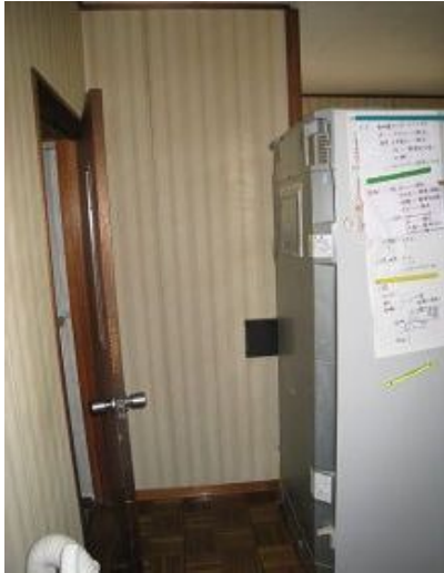
施工前(台所側)
