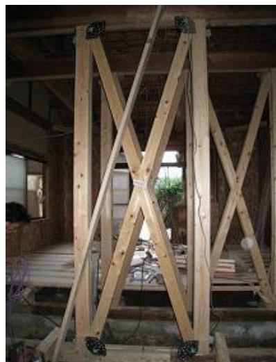
筋交ダブル90×90取付 完了
