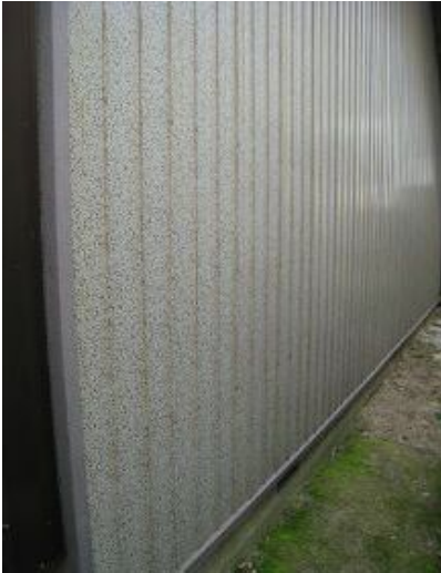
施工前(外部側)
