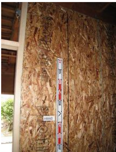
構造用パネル(OSB)N50@150固定
