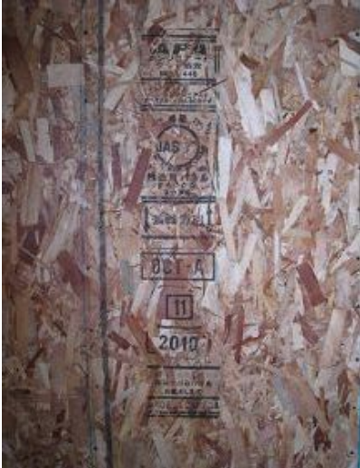
面材耐力壁用 構造用パネル OSB 厚=9mm
