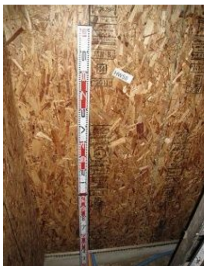
構造用パネル(OSB)N50@150固定(浴室側完了)
