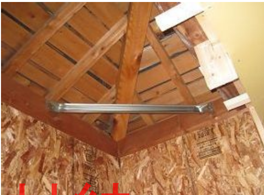
鋼製火打ち取付
