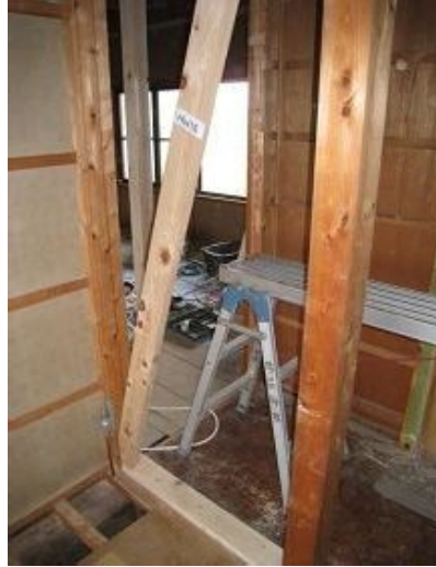
筋交:45×90取付(端部金物固定)
