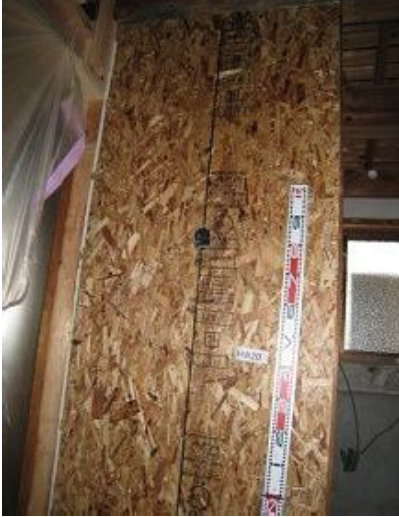
構造用パネル(OSB)N50@150固定
