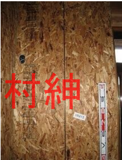
構造用パネル(OSB)N50@150固定
