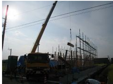
1階部分柱・2階床梁建て込み
