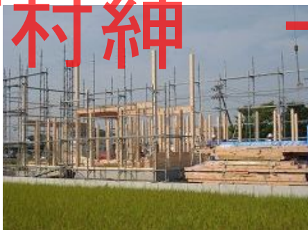
2階床梁建て込み
