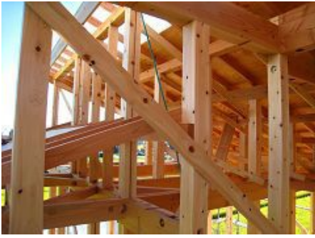
小屋組み 雲筋交い確認
