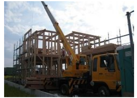
軒桁・小屋梁建て込み
