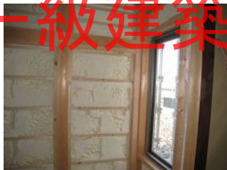
壁断熱材 発泡ウレタン吹付け
