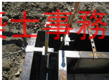
ホールダウン金物用アンカーボルトM16 ⑨
