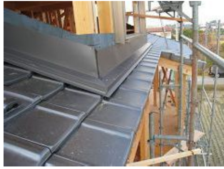
水切り板金取付 バルコニー屋根
