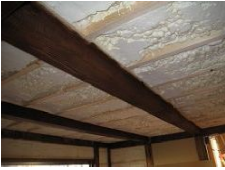
天井断熱材 発泡ウレタン吹付け
