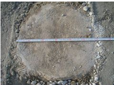
杭径確認 \Phi 600\text{mm} 以上
