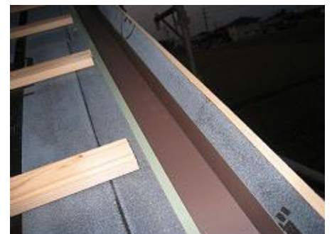
端部押さえ板金確認
