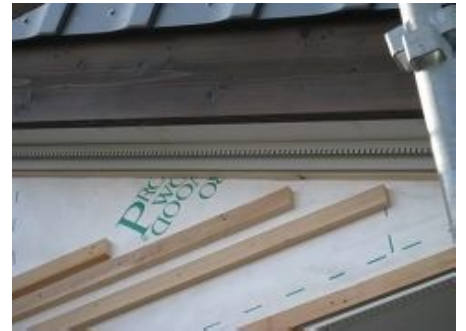
軒裏換気口取付
