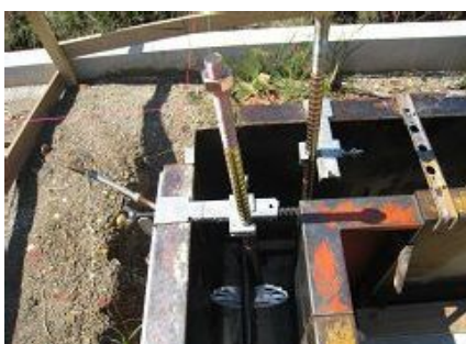
ホールダウン金物用アンカーボルトM16 ⑪
