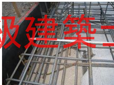
FG7 上主筋: 2-D13 下主筋: 2-D13 ST: D10@200
