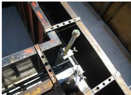
ホールダウン金物用アンカーボルトM16 ④
