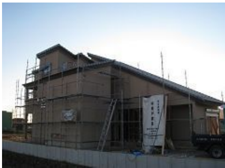
外壁塗装 リシン吹付け
