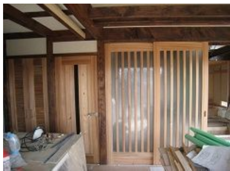
内部木製建具 吊り込み確認
