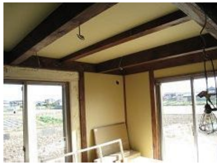
壁・天井 plasterボード下貼り
