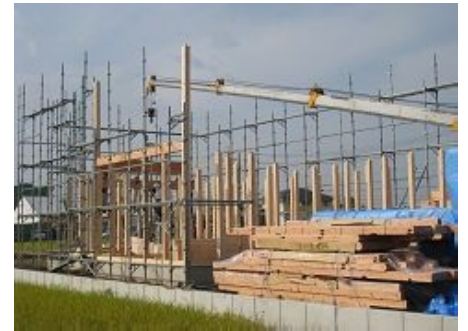
1階部分柱・2階床梁建て込み
