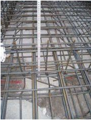
FG4a 上主筋: 2-D13 下主筋: 2-D13 ST: D10@200 腹筋: 1-D10
