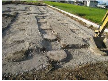
アプローチ・車庫部分
