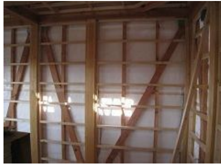
内装壁下地 胴縁取付
