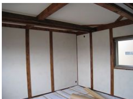
壁・天井 珪藻土塗り完了
