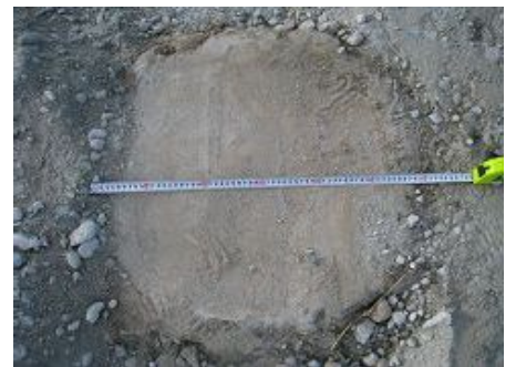
杭径確認 \Phi 600\text{mm} 以上
