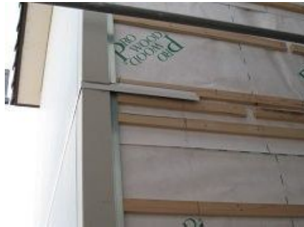
ジョイント部分水切り板金取付
