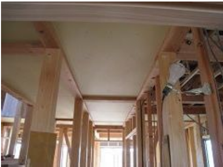
天井 plasterボード貼り
