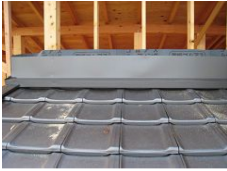
水切り板金取付 バルコニー屋根
