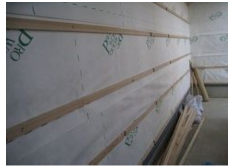
通気胴縁及び水切り板金取付
