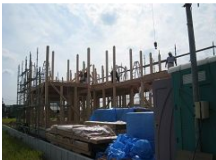
2階管柱建て込み
