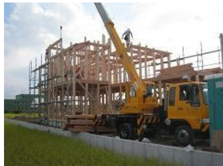
2.5階部分柱・梁建て込み
