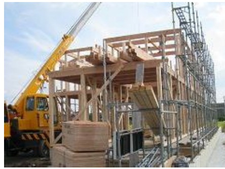
軒桁・小屋梁建て込み
