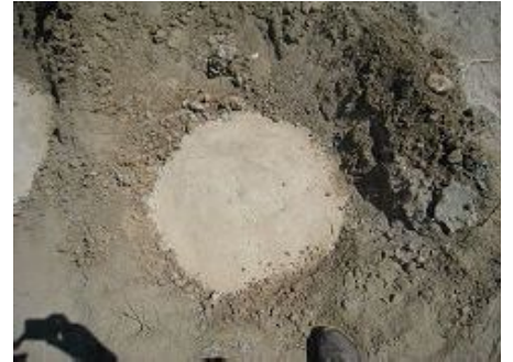
杭頭処理完了
