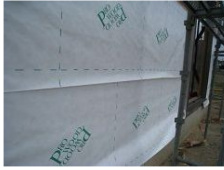
外壁防水下地 透湿防水シート
