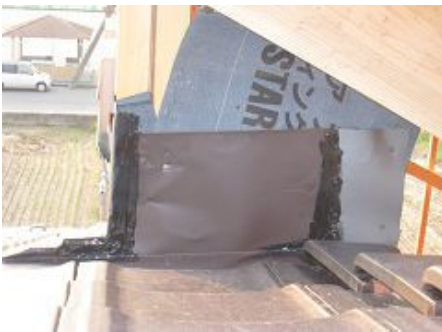
谷部分は正指示後手直し確認 防水層の立ち上がり不足のため手直し
