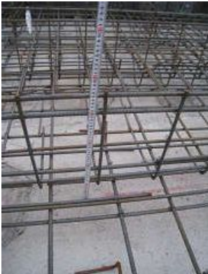
FG5 上主筋: 2-D13 下主筋: 2-D13 ST: D10@200 腹筋: 1-D10
