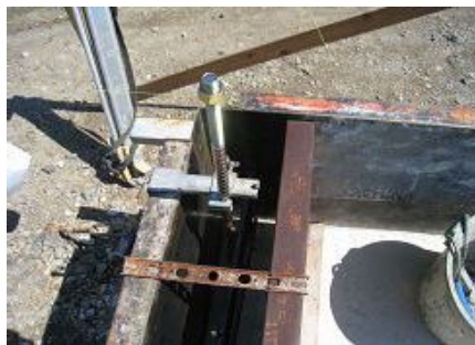
ホールダウン金物用アンカーボルトM16 ①
