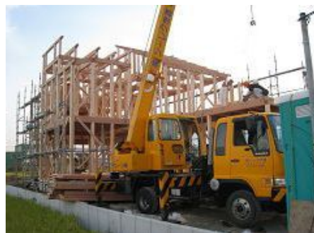
小屋束・母屋建て込み
