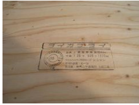
構造用合板(床下地)固定用釘 N75 構造用合板(床下地)t28mm
