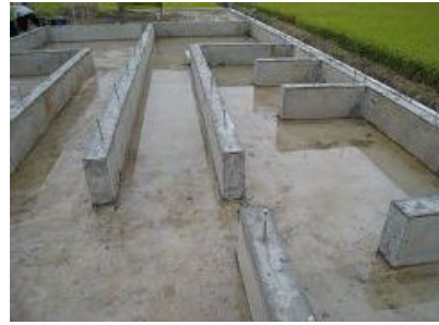
階段・廊下・トイレ・洗面部分
