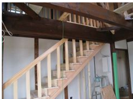
内部造作工事
