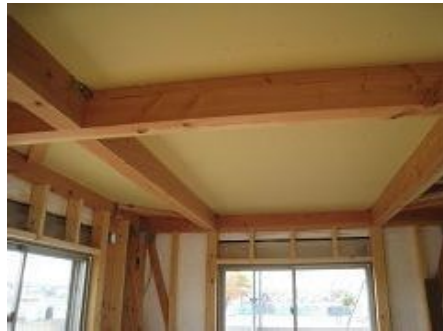
天井 plasterボード貼り
