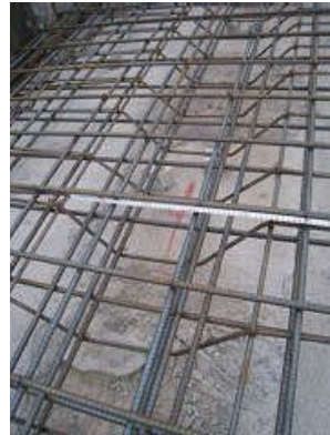
FG6 上主筋: 2-D13 下主筋: 2-D13 ST: D10@200
