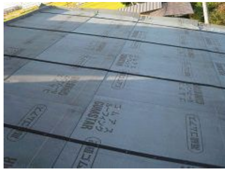
屋根防水下地アスファルトルーフィング敷き
