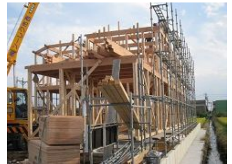
小屋束・母屋建て込み
