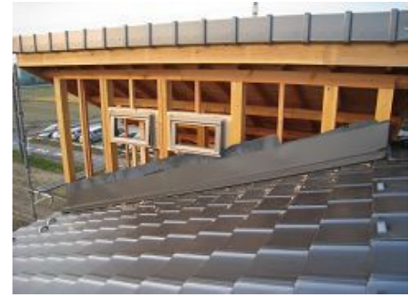
水切り板金取付 2階大屋根
