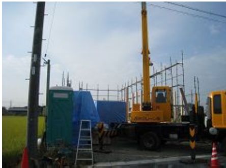
通し柱建て込み
