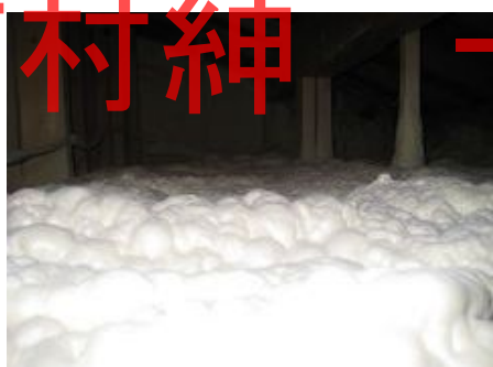
小屋裏 断熱材 発泡ウレタン吹付け シックハウス対策 換気扇
