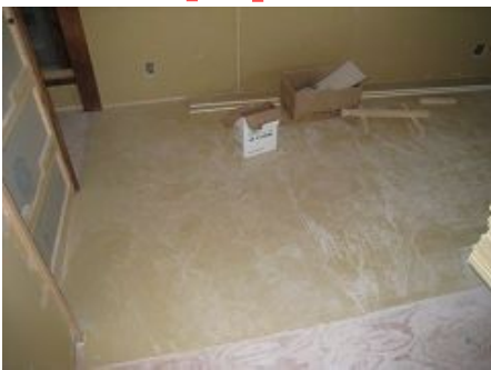
2階、2.5階床下地 plasterボード貼り
