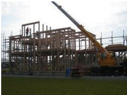
2.5階部分柱・梁建て込み
