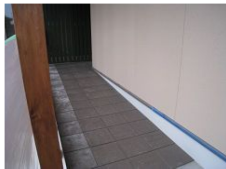
アプローチタイル貼り
