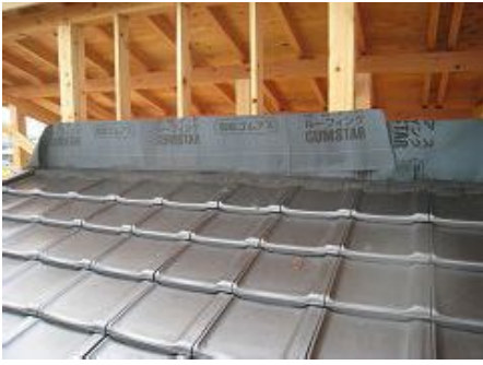
下屋部分瓦葺き
