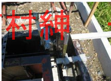
ホールダウン金物用アンカーボルトM16 ⑦
