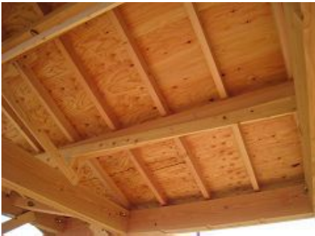
屋根下地 垂木・構造用合板確認
