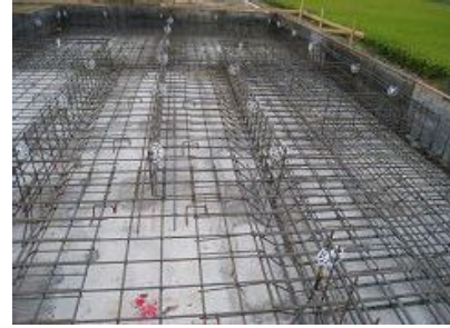
階段・廊下・トイレ・洗面所 浴室部分
