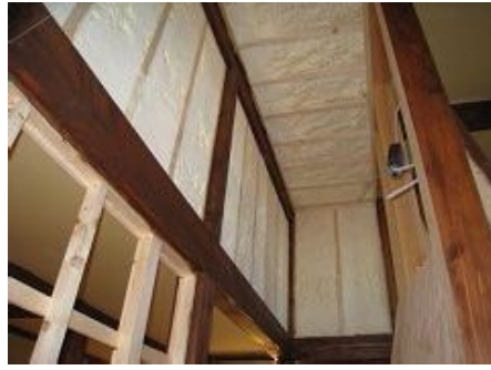
壁・天井断熱材 発泡ウレタン吹付け
