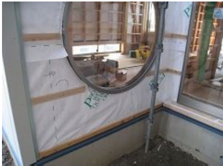
通気胴縁及び水切り板金取付
