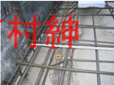
FG7 上主筋: 2-D13 下主筋: 2-D13 ST: D10@200
