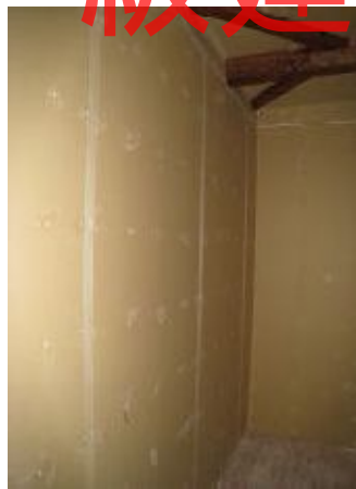
壁・天井 plasterボード下貼り
