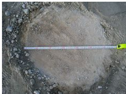
杭径確認 \Phi 600\text{mm} 以上
