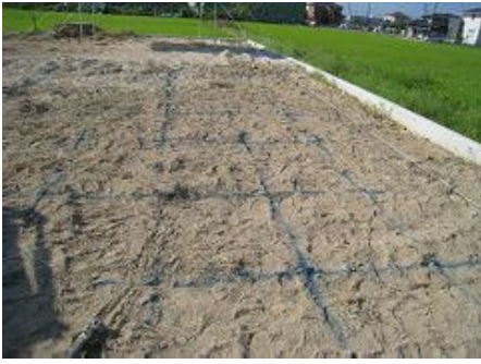
柱状改良杭芯位置出し
