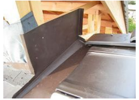
谷部分板金確認
