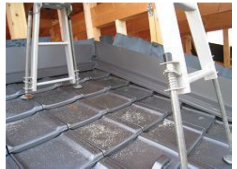
水切り板金取付 バルコニー屋根
