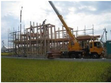
軒桁・小屋梁建て込み
