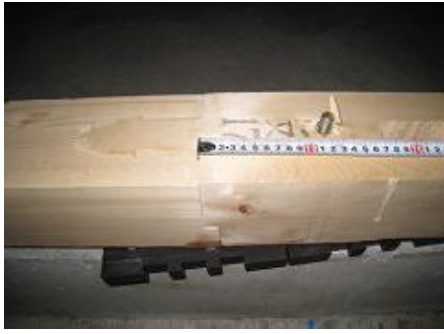
土台継ぎ手部分 アンカーボルト確認
