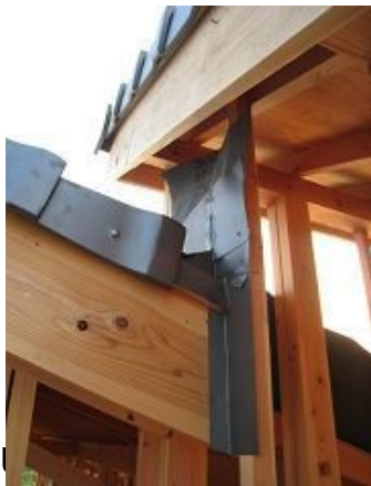
谷部分は正指示後手直し確認 防水層の立ち上がり不足のため手直し
