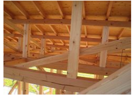
小屋組み 雲筋交い確認
