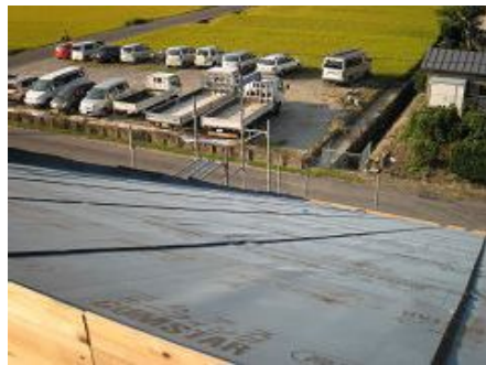
屋根防水下地アスファルトルーフィング敷き
