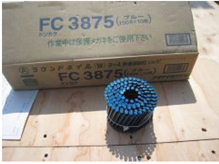
構造用合板(床下地)固定用釘 N75 構造用合板(床下地)t28mm
