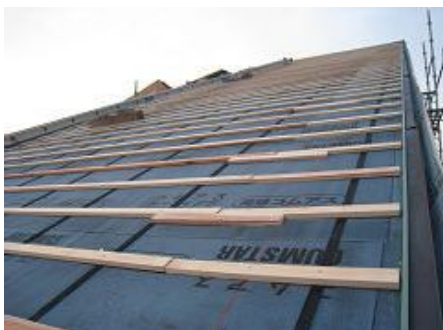
屋根瓦固定用棧取付
