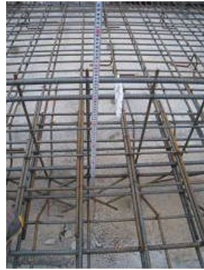
FG4b 上主筋: 2-D16 下主筋: 2-D16 ST: D10@200 腹筋: 1-D10
