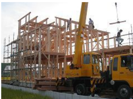
小屋束・母屋建て込み
