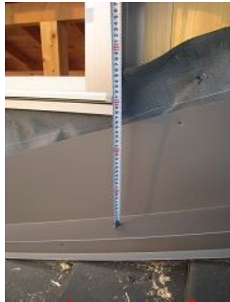
サッシ下端水切り立上り高さ=200mm
