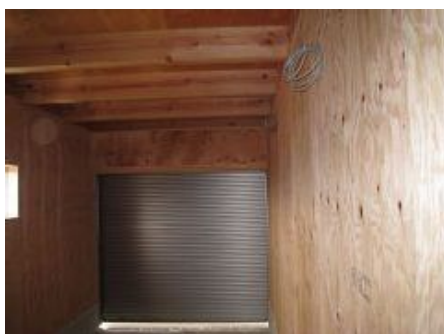
車庫 針葉樹合板仕上げ完了
