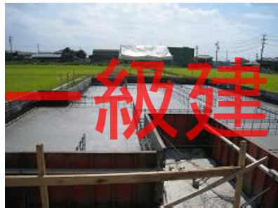
ベース部分コンクリート打設
