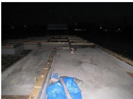
アプローチ・車庫部分
