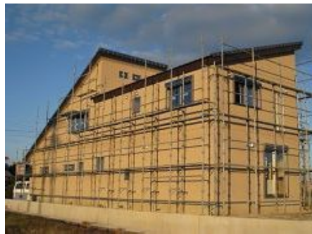
外壁塗装 リシン吹付け
