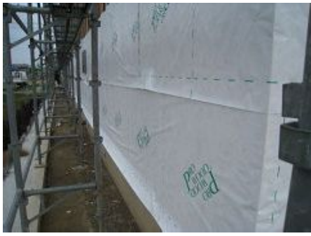
外壁防水下地 透湿防水シート
