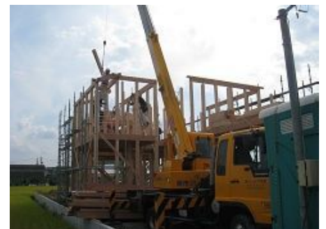
軒桁・小屋梁建て込み
