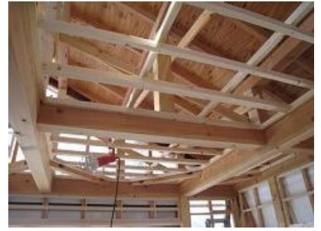
内装天井下地 野縁取付
