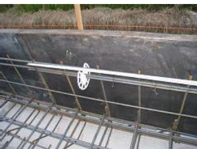
定着長さ 40d以上 13 \times 50 = 520\text{mm}
