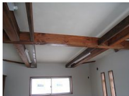
内部造作工事
