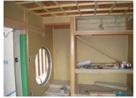
壁 plasterボード貼り
