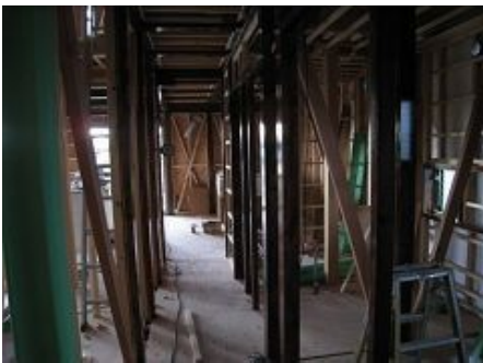
構造表し部分(柱・梁・筋交)匠の塗油塗装
