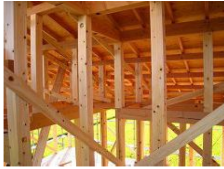
小屋組み 雲筋交い確認
