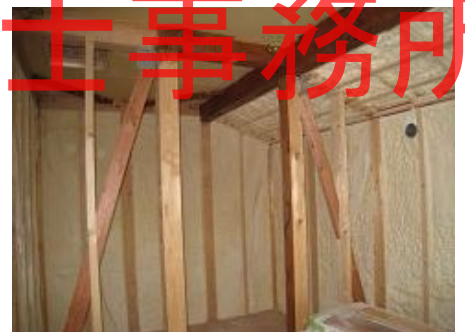
壁・天井断熱材 発泡ウレタン吹付け
