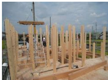
2階管柱建て込み
