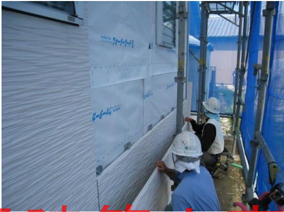
外壁サイディング厚10mm金物固定
