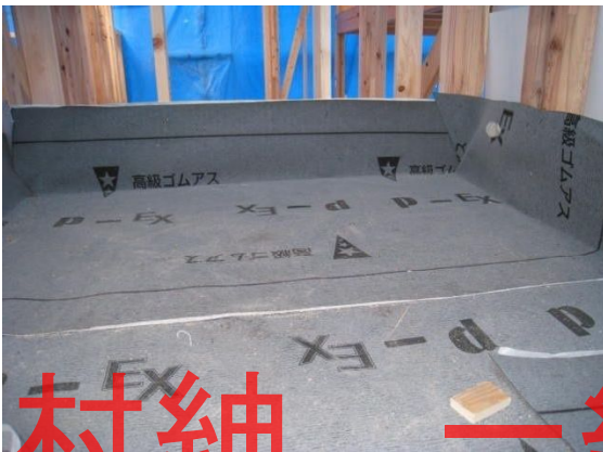
玄関底部分アスファルトルーフィング
