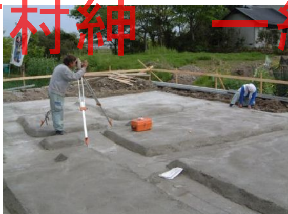
捨てコンクリート t=50\text{mm} 墨出し
