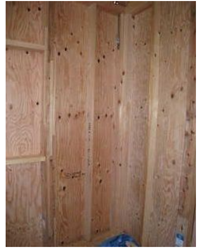
Y1通りX8.5-X10 X10通りY1-Y2 構造用合板t=9、N50@150固定
