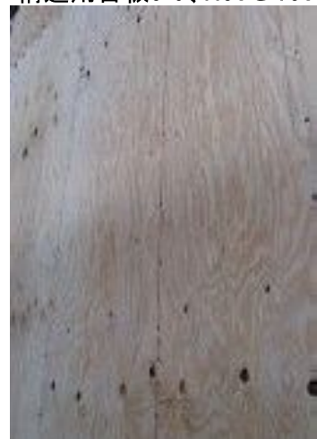
X10通りY1-Y2 構造用合板t=9、N50@150固定
