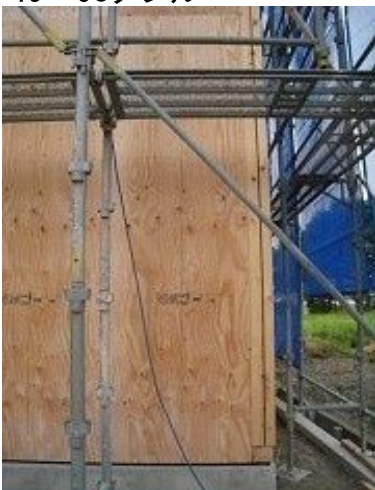
Y1通りX8.5-X10 構造用合板t=9、N50@150固定
