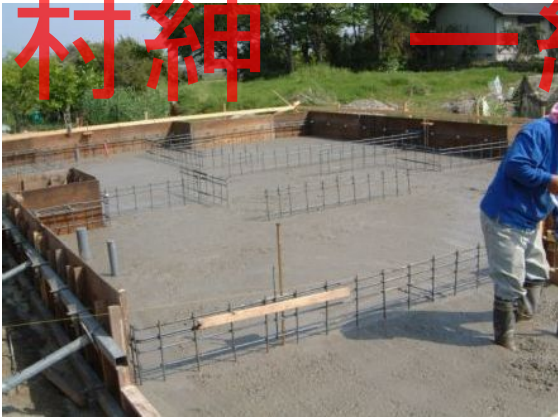
基礎コンクリート打設
