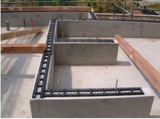
基礎ハッキン敷設
