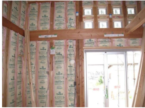
壁断熱材:グラスウール t=100\text{mm}
