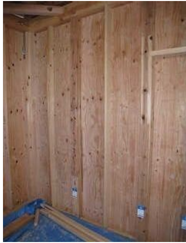
Y1通りX7.5-X8.5 構造用合板t=9、N50@150固定
