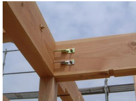
梁接合部羽子板ボルト固定
