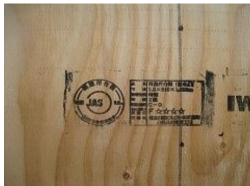
構造用合板 t=9.0\text{mm}
