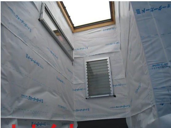
開口部廻り防水テープ固定
