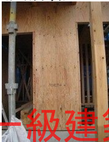
Y1通りX3-X4.5 構造用合板t=9、N50@150固定
