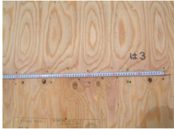
床構造用合板N75@150固定
