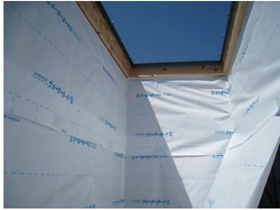
外壁透湿防水シート張り
