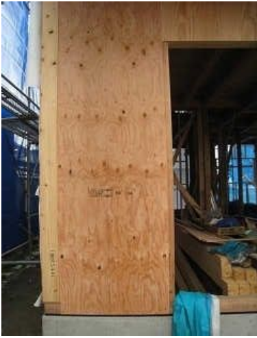
Y1通りX0-X1 構造用合板 t=9 、N50@150固定
