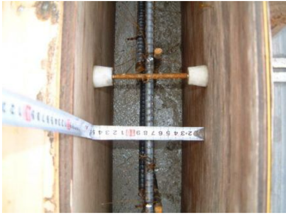
立ち上がり型枠 幅=150mm
