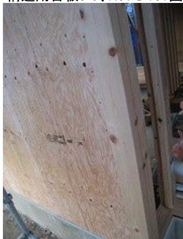
X10通りY5-Y6 構造用合板t=9、N50@150固定
