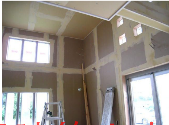
壁下地パテ処理
