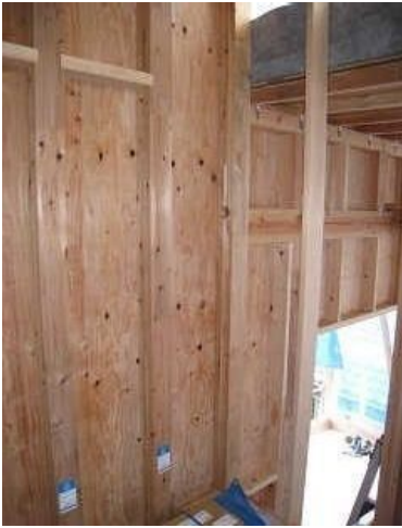
Y1通りX4.5-X5.5 構造用合板t=9、N50@150固定
