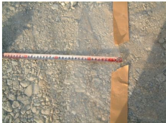
フィルム重ね巾 \geq 15\text{cm} 以上
