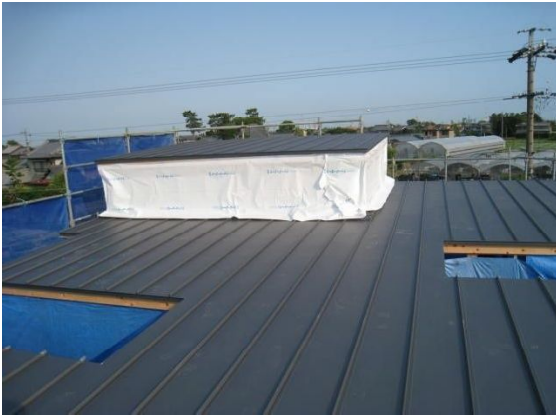
立ち上がり部分外壁防水シート張り
