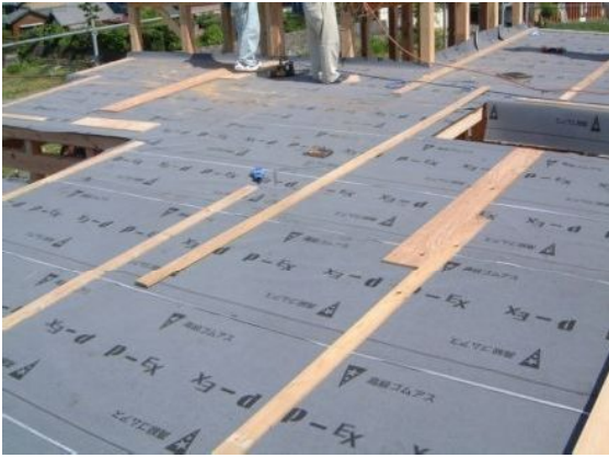
屋根防水アスファルトルーフィング敷き
