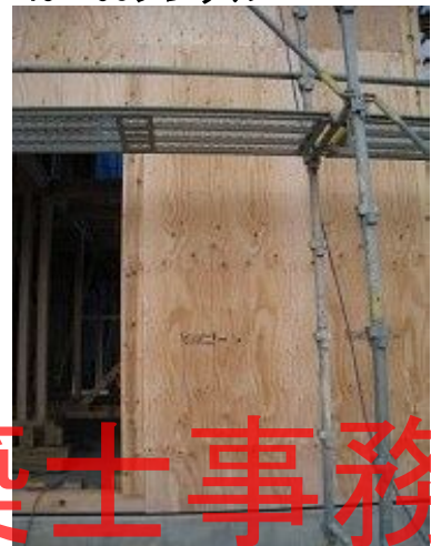
Y1通りX7.5-X8.5 構造用合板t=9、N50@150固定
